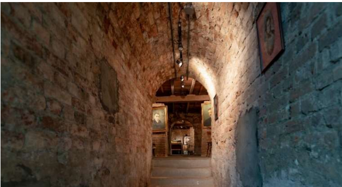
Foto 4,5,6,7, Estado de Cielos, Paredes, Ventanería, Sótano. Causa: Humedad por Filtración y por Capilaridad Fuente: Ing. Wagner Calderón Rizo, Fecha Junio del 2020
