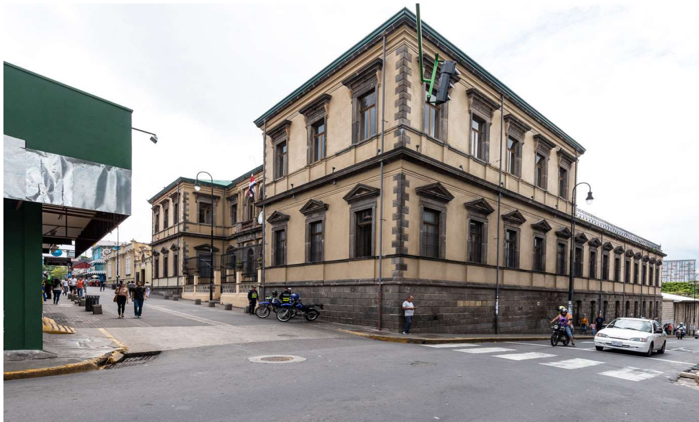
Foto 13. Vista de fachadas oeste y sur.
