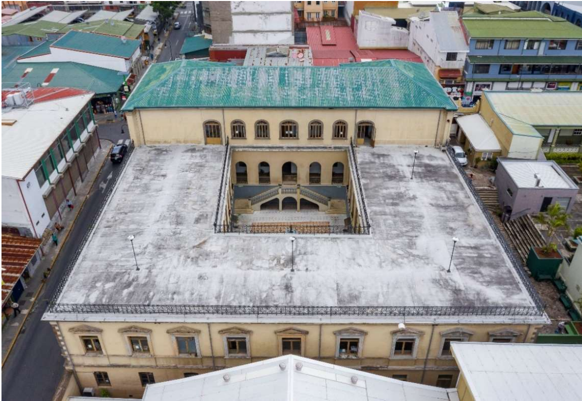
Foto 5. Vista aerea de la losa, vista desde el costado este.
