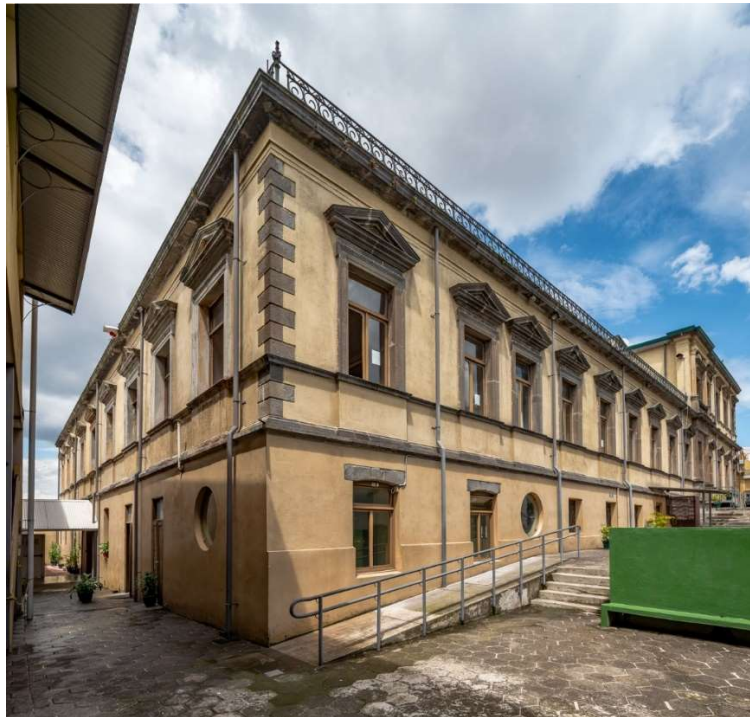
Foto 12. Vistas de fachada este y norte.
