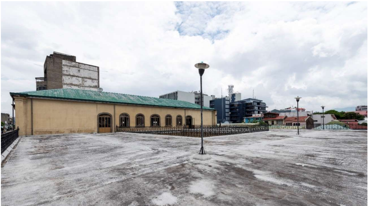
Foto 7. Vista de la losa en estado seco.
