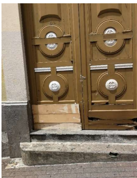
Foto 24, 25, 26, 27. Detalle de Puertas, Causa: deterioro total, producto a la presencia de elementos atmosféricos como la lluvia, el viento, las temperaturas, las humedades o la insolación, sensible al ataque de insectos y otros animales como palomas y murciélagos que han provocado daños biológicos y estéticos, Fuente: Arq. Jorge Omar Vega Rosales, Fecha Junio del 2020
