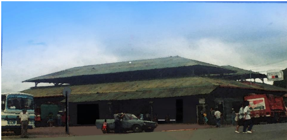
Fig. 4 Vista Noreste, con Cubierta color Verde alrededor 1990
