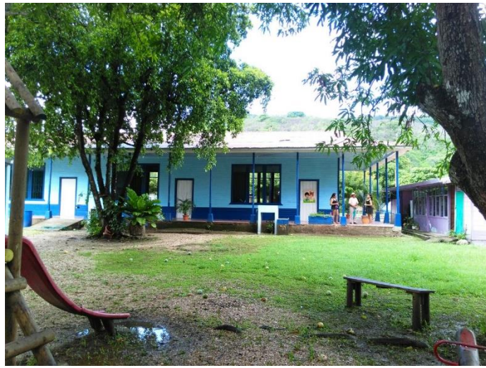
Figura 13 Vista trasera de escuela
